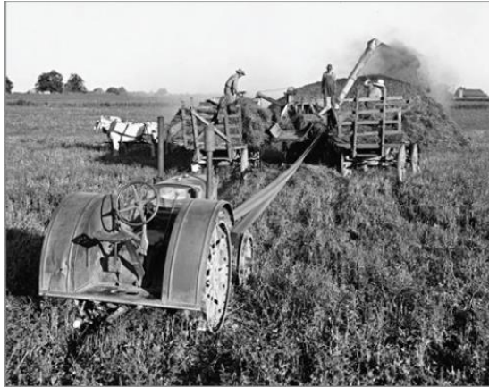
Figura 2. Tractor que acciona una máquina trilladora de correa de la década 1920.
