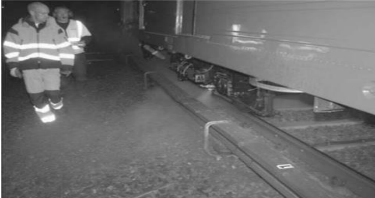
Figura 37. Lavado de rieles a alta presión [43].
