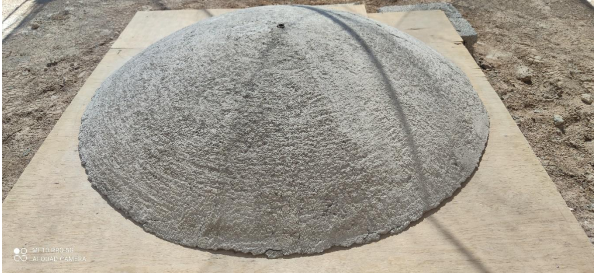
Figura 24- Base de triplay y molde de concreto.
