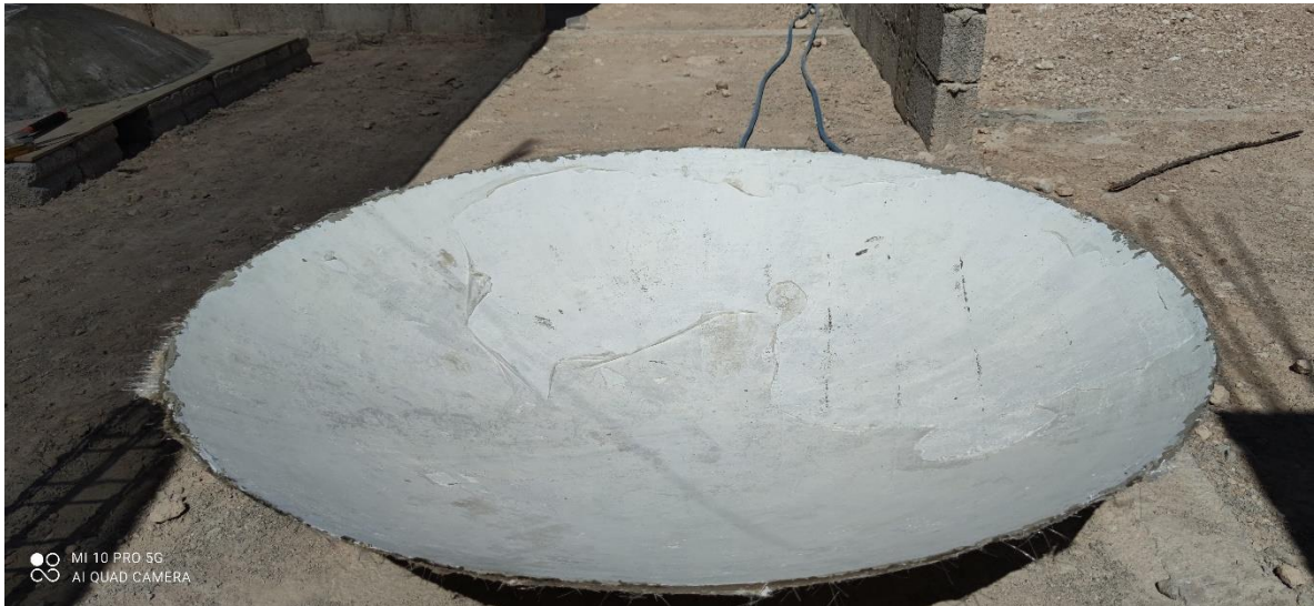
Figura 33- Concentrador Parabólico desmoldado.
