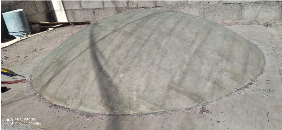
Figura 32- Aplicación de la Resina PP-250 y Catalizador K-2000.
