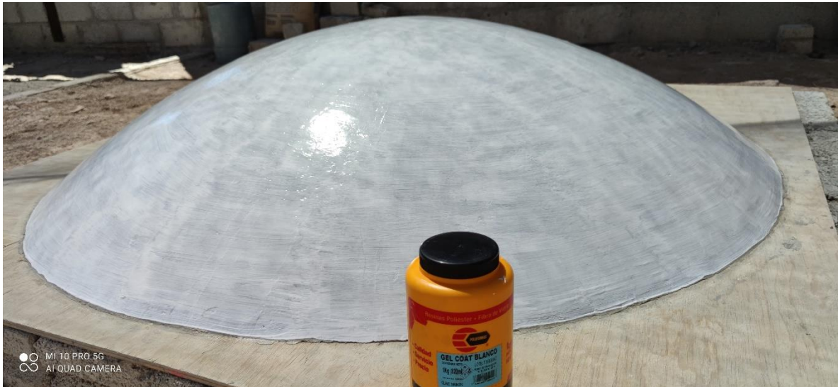
Figura 29- Aplicación del Gel Coat Blanco.
