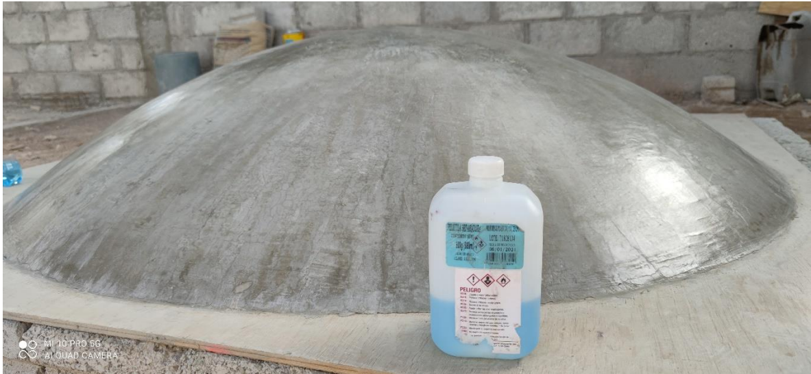
Figura 28- Aplicación de la película separadora.
