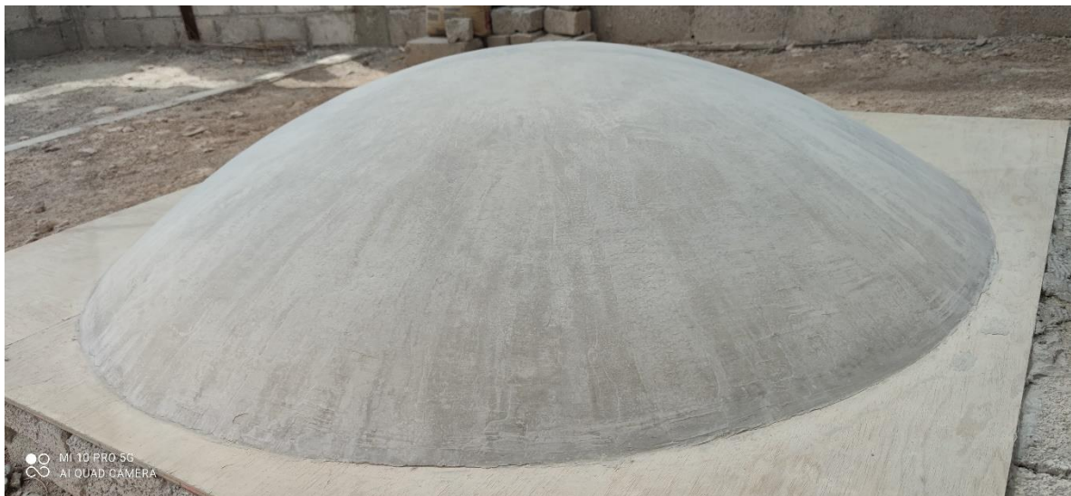
Figura 27- Aplicación de la cera desmoldante CP-500.
