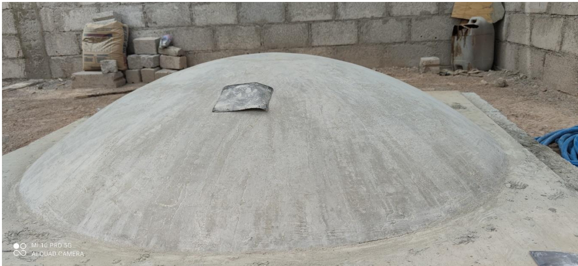
Figura 25- Acabado pulido del molde de concreto.
