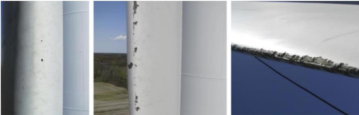
*Figura 1. Borde de ataque de una pala erosionada por partículas (Damiani, 2018)*
